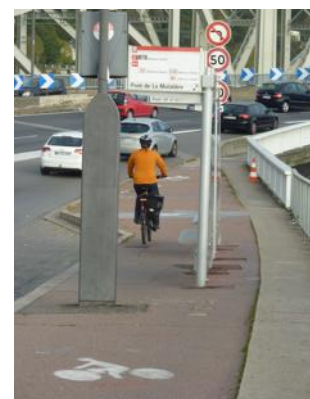
■ L'actuel passage pour les vélos, sur le pont de La Mulatière. Photo archives DR
