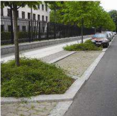
Stationnement bilatéral en alternance avec des arbres d'alignements plantés en massifs
